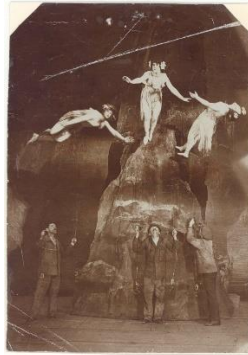
A Rajna kincse sellőit mozgató szerkezet működés közben, 1907
